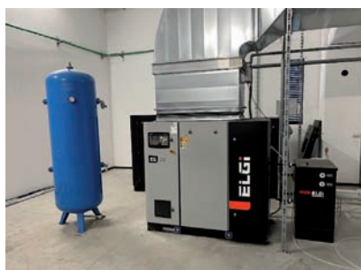
Compressore rotativo a vite ELGi modello EG22V con sistema di recupero di calore HRI.
