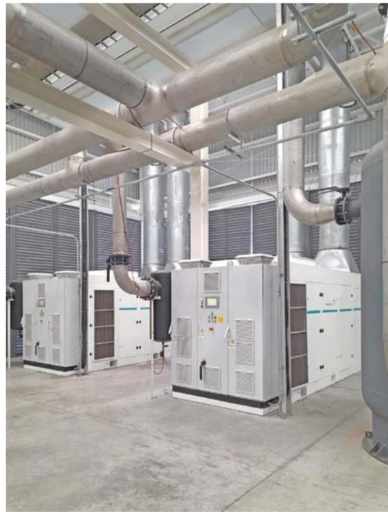
Compressori A520 installati in Messico nel 2024 con VS, da 320 kW ciascuno, raffreddati ad aria, per la produzione di lattine, 2022.
