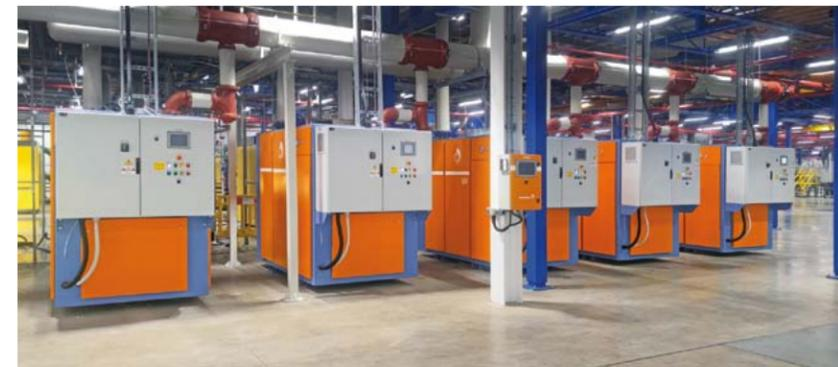
Pompe per vuoto Pneumofore UV50 con VS, raffreddate ad aria, presso VacMan in Gran Bretagna per la produzione di lattine, 2024.
