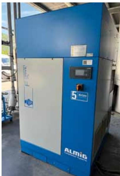
**Il compressore con motore a magneti permanenti raffreddato ad olio F-DRIVE 75.**
