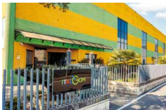
Vista esterna del capannone.
