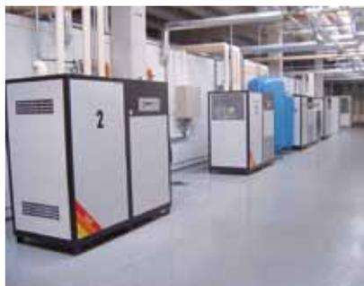
Un impianto per la generazione d'azoto con macchine Isolcell.
