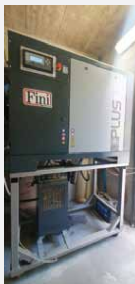
Compressore Fini Plus 22 kW a 15 bar.
