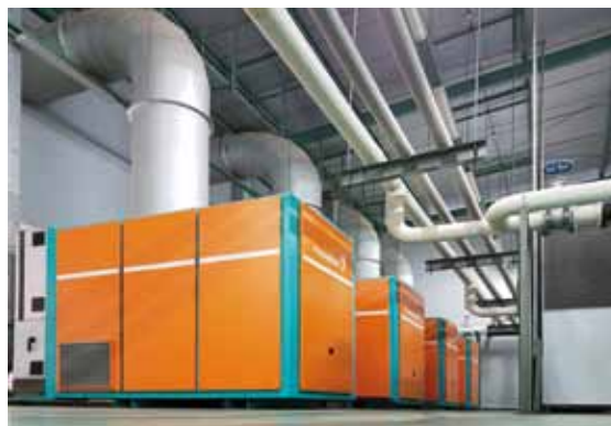
Compressori Pneumofore A180 con variatore di frequenza installati in Indonesia.
