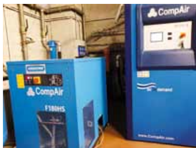
Uno dei compressori L30RS e l'essiccatore F180HS.
