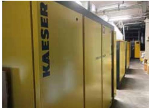
Vista della sala compressori, in primo piano la nuova unità da 160 kW, in fondo il nuovo essiccatore TG 650.
