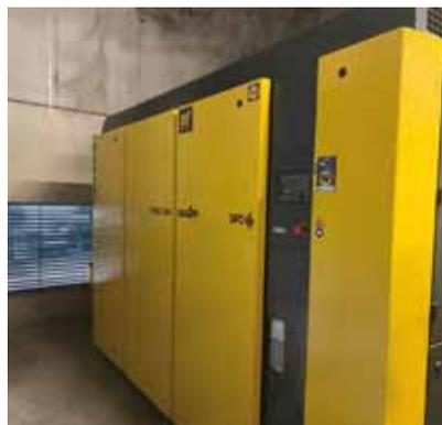
Nuovo compressore a vite lubrificato, potenza da 160 kW con recupero del calore.
