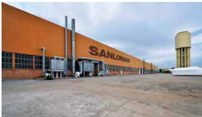
Il cantiere di Massa.
