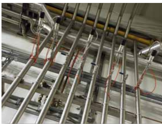
Il flusso in questi tubi è misurato con i misuratori VPFlowScope della VPInstruments.
