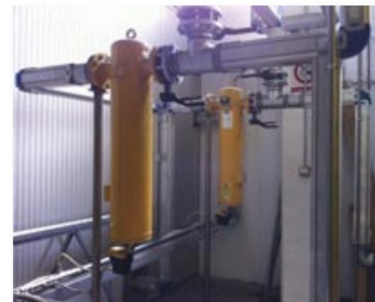
stribuzione, provvedere all'acquisto di un essiccatore e di un opportuno sistema di filtraggio per ottenere una classe di purezza dell'aria richiesta nelle specifiche di processo.
