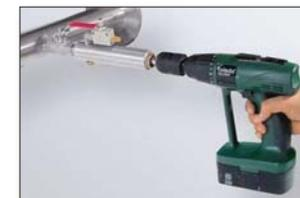
Perforazione del tubo in pressione.
