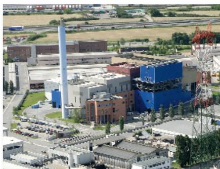
Realizzazione e gestione di un termovalorizzatore per la provincia di Piacenza. E' quanto ha fatto e sta facendo Tecnoborgo Spa. Così, per valorizzare quanto il rifiuto può ancora dare, anziché portarlo in discarica, se ne utilizza il potere calorifico residuo per produrre vapore che, fatto espandere in un turboalternatore, genera energia elettrica. Quanto all'aria compressa, tecnologia Boge.
