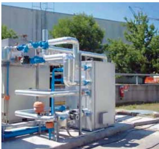
Fig. 1 - L'assorbitore di potenza frigorifera nominale pari a 100 kW considerato nell'esempio citato nell'articolo, il cui azionamento è operato con acqua calda alla temperatura di 88 °C.
