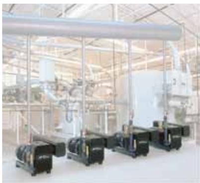
**Fig. 4 - Pompa a camme Elmo Rietschle Zephyr applicata in un trasporto di materiale plastico.**
