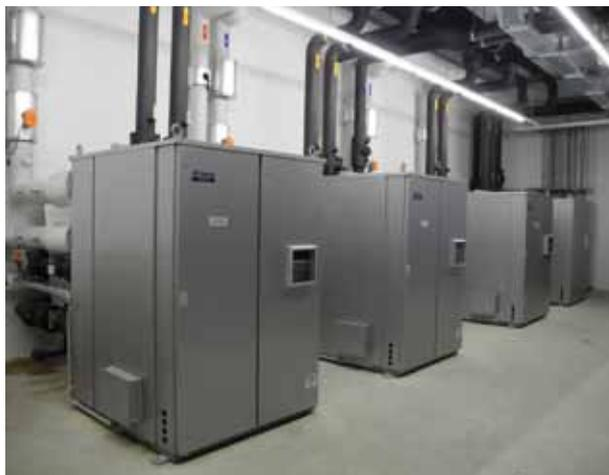
Fig. 2 - I chiller ad assorbimento modulari serie WFC possono essere installati sia in esterno sia nel locale tecnico.
