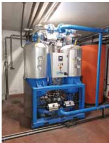
L'essiccatore ad adsorbimento Ethafilter.
