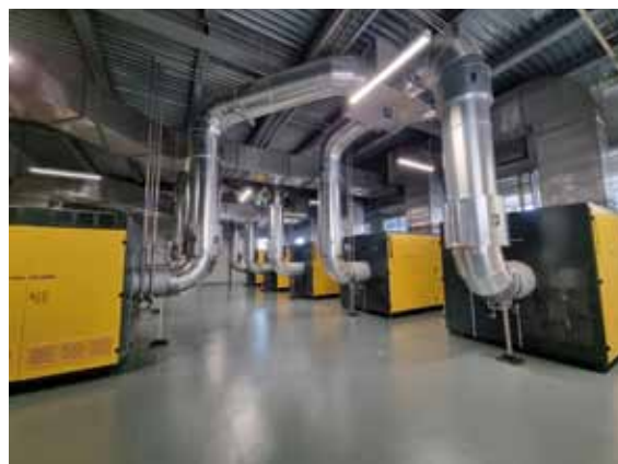
Un impianto di turbosoffianti.
