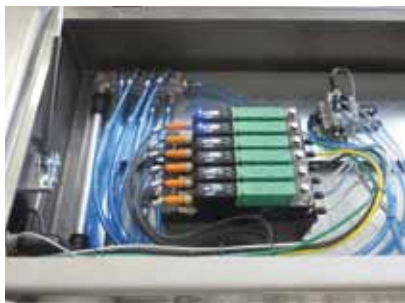
Eiettori piCOMPACT23 SMART montati sulla struttura superiore del flexpicker nel sistema di confezionamento di Tecno Pack.
