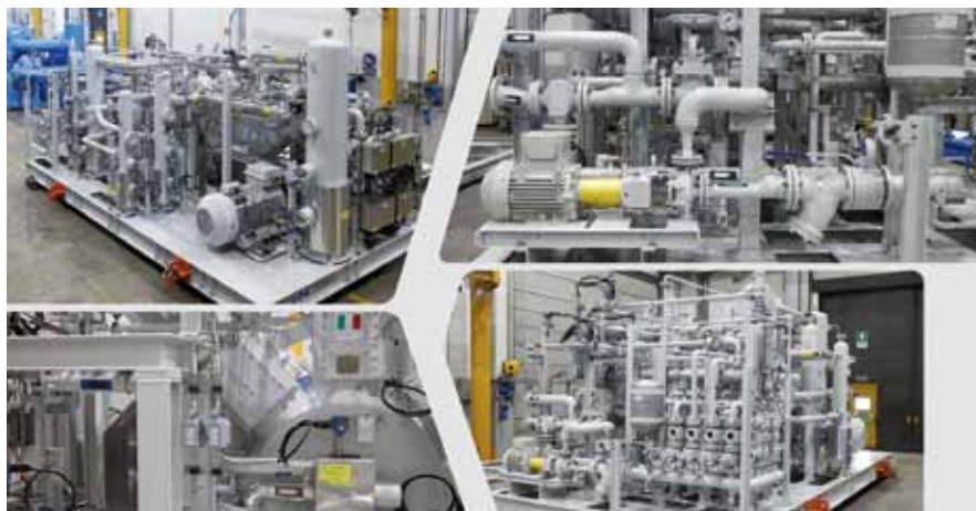
Immagine dell'unità di trattamento dell'idrogeno.
