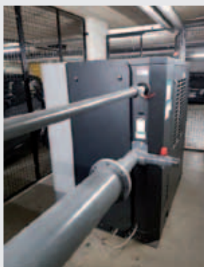
L'installazione del compressore presso il France Rugby Club.
