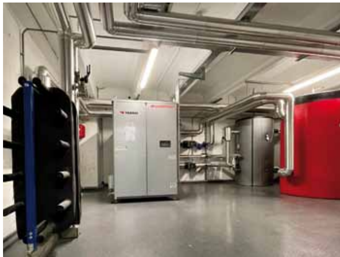
La nuova centrale frigorifera con l'assorbitore Maya Yazaki WFC SC 30.
