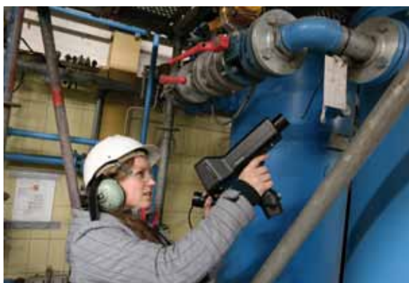
Trovare perdite di aria compressa con gli ultrasuoni.
