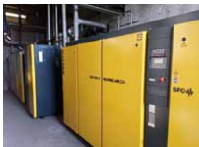
La sala compressori.
