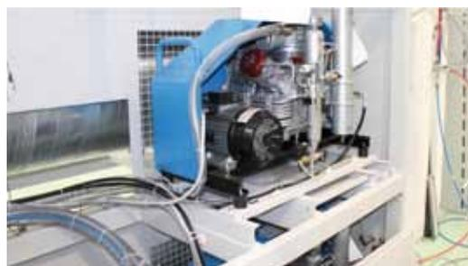
Compressore mod. MCH 13 STANDARD versione Elio in approntamento sul sistema impianto di recupero gas.
