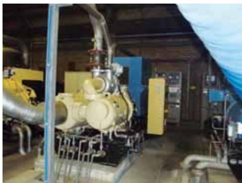
**Importante vetreria italiana. Produzione vetro cavo: 8 compressori centrifughi Ingersoll Rand C700, portata 115 mc/min cad, pressione 4 bar g, aria di processo per macchine IS.**
