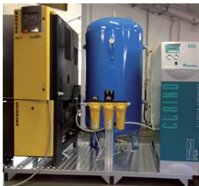
Il sistema Plug&Play su skid per i generatori di azoto.
